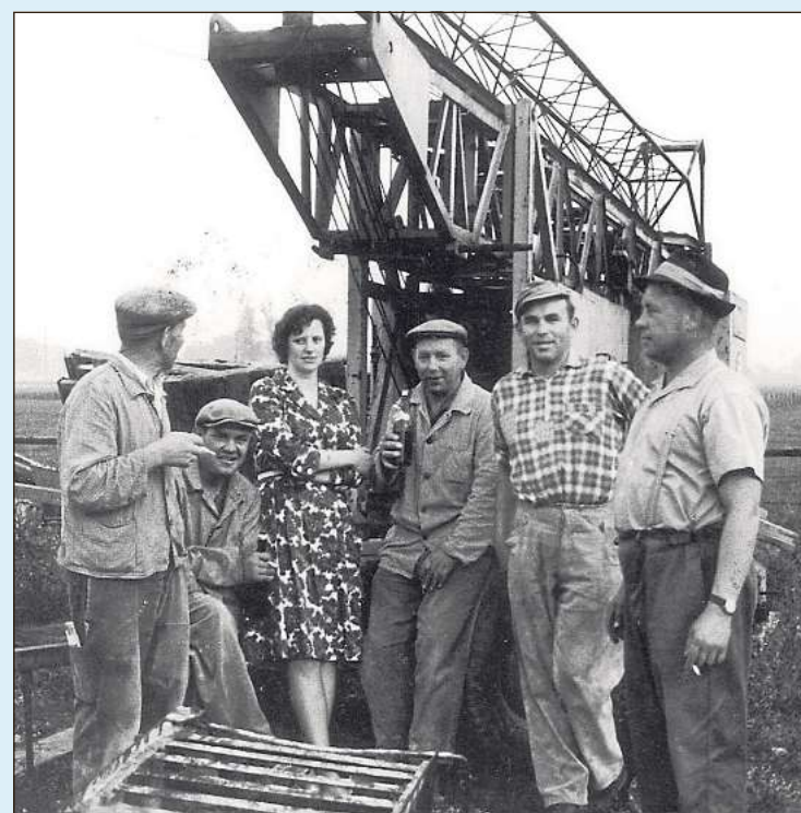
Als die Firma Freitag ihren ersten eigenen Kran anschaffte, war dies der Anlass für eine kleine Feier.
